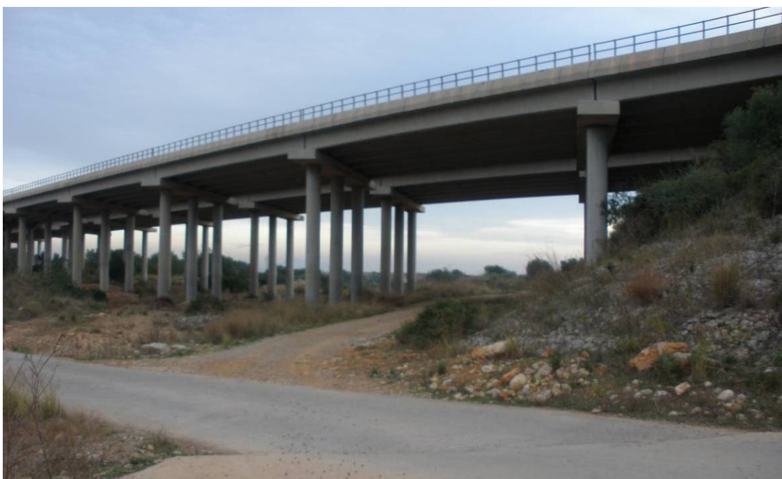
Vista del terraplén conformante del tronco de la AP-7, a la altura del viaducto posterior a la hinca previsto bajo la vía de comunicación
