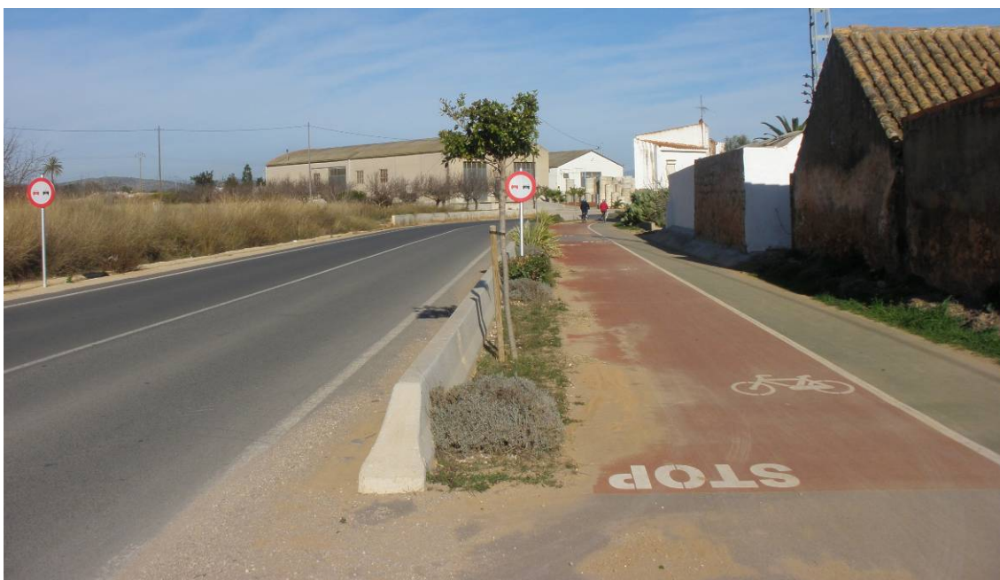
Detalle de la bionda separadora de vial para tráfico rodado y el carril bici
