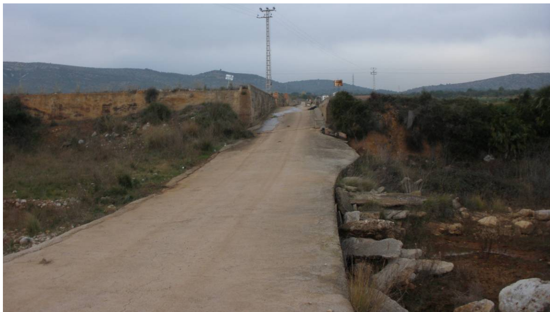
Vista en primer plano del camino hormigonado por el que discurre el trazado
