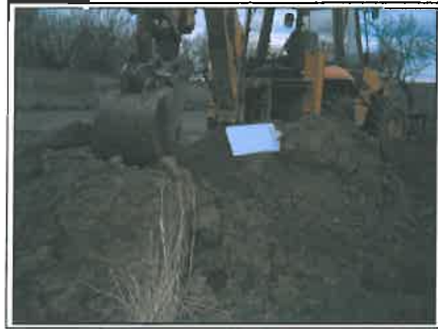
FOTO 2: Acopios de la calicata mecánica nº 1.
