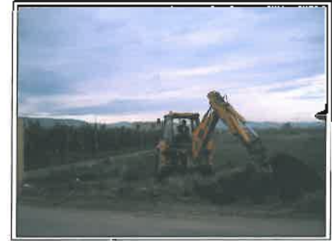
FOTO 4: Situación y realización de la calicata mecánica nº 2.
