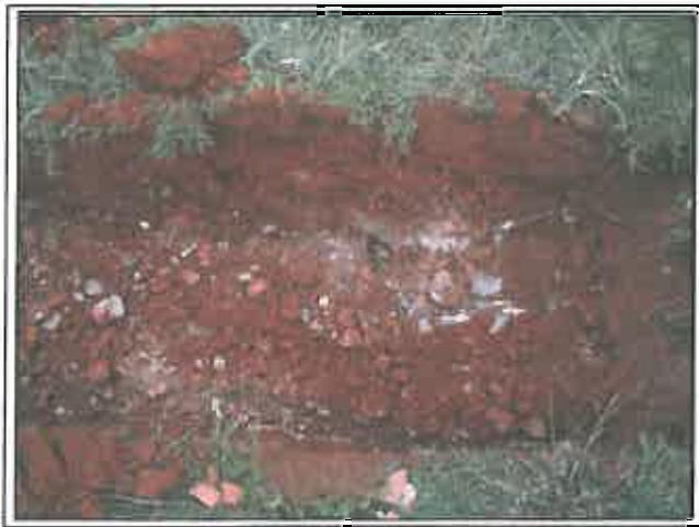
FOTO 13: Calicata mecánica nº 4.
