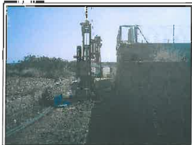
FOTO 2: Emplazamiento y realización del sondeo mecánico n° 1.
