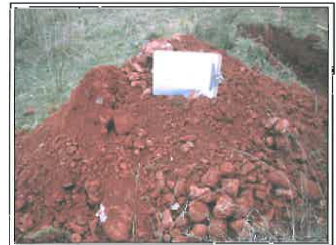
FOTO 12: Acopios de la calicata mecánica nº 4.
