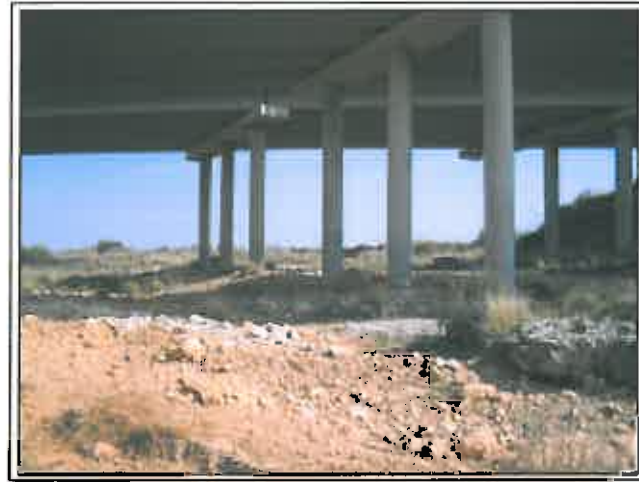
FOTO 18: Vista de las gravas en la Rambla de Alcalá.
